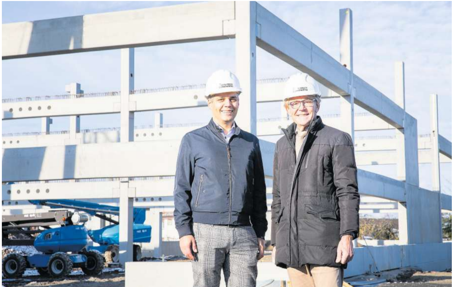
Vater und Sohn haben gut lachen: David (links) und Toni Meier auf der Baustelle in Mörschwil.
